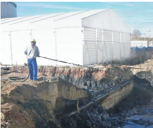
Un agent des services de terrain applique Petro-Fix par pulvérisation sur les parois et en fond de fouille.
