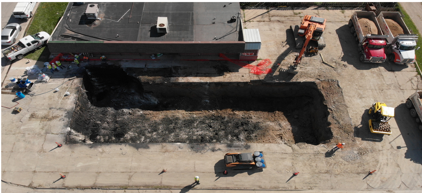
Esempio di applicazione di PetroFix all'interno di uno scavo
