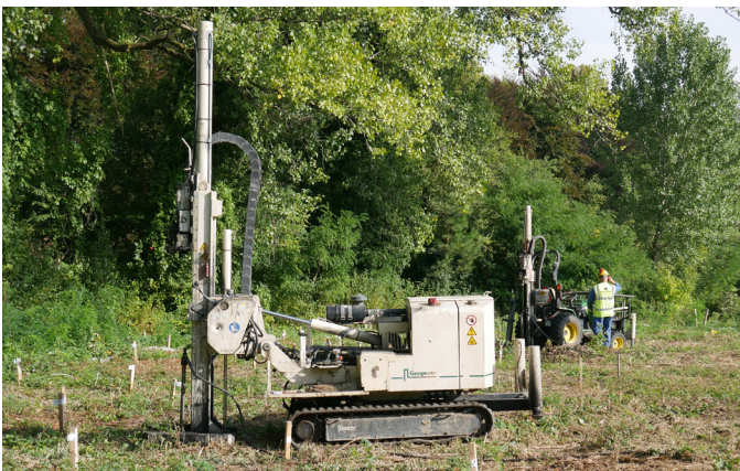
Fase di iniezione Direct Push
