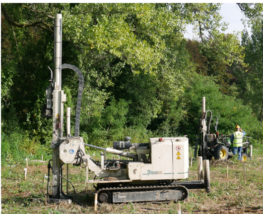
Fig. 5: Fase de inyección de empuje directo
