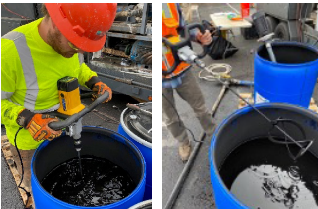
Fig. 2: Homogeneización de PetroFix usando una batidora manual
