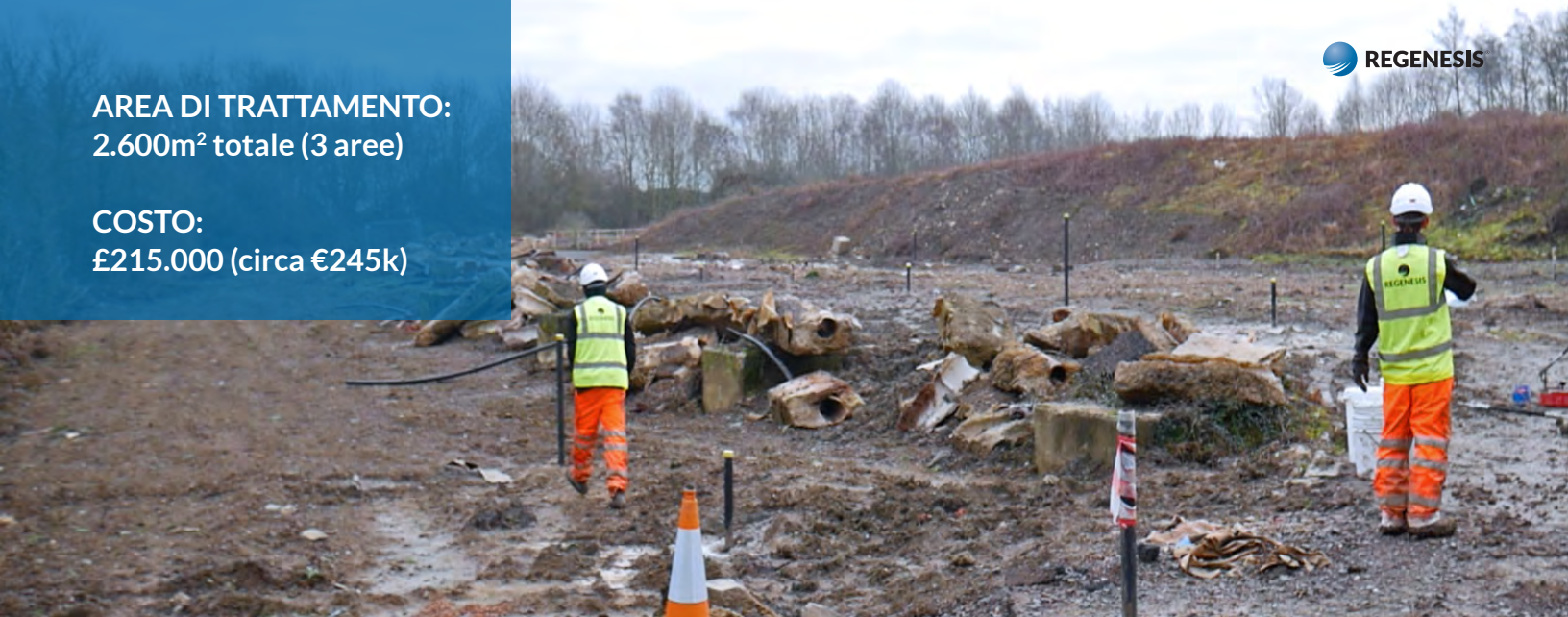
Fig.5 Trattamento full-scale: griglia di iniezione nell'area sorgente 1
